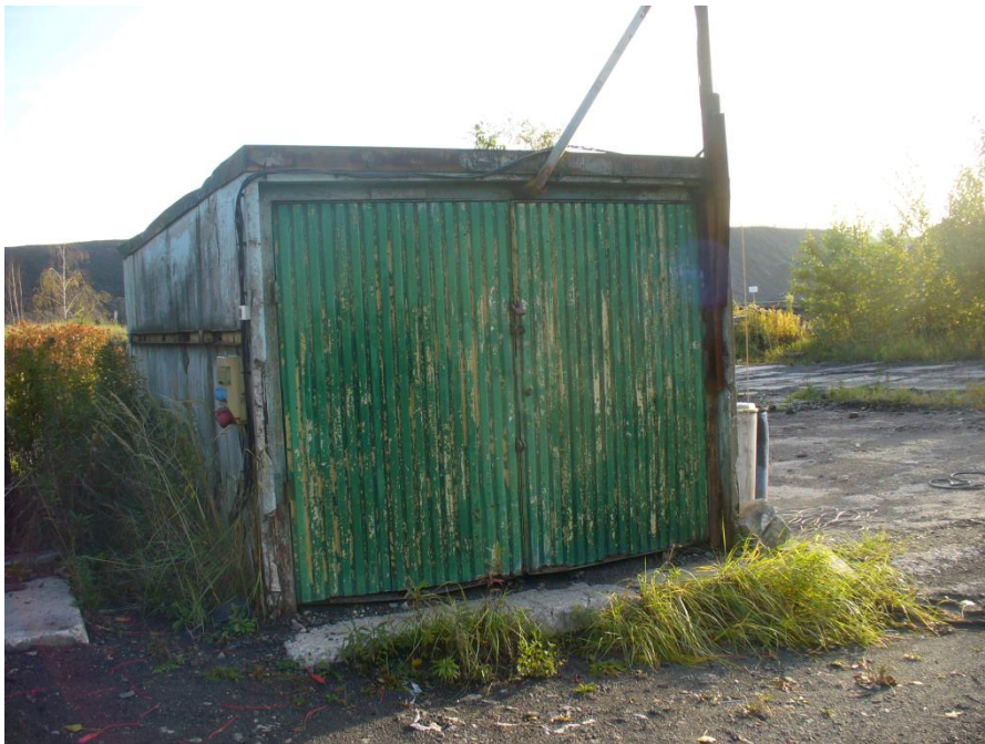
Fot. 9. Budynek garażu.
