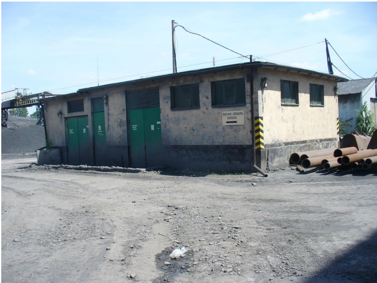
Fot. 12. Budynek rozdzielni głównej 6kV
