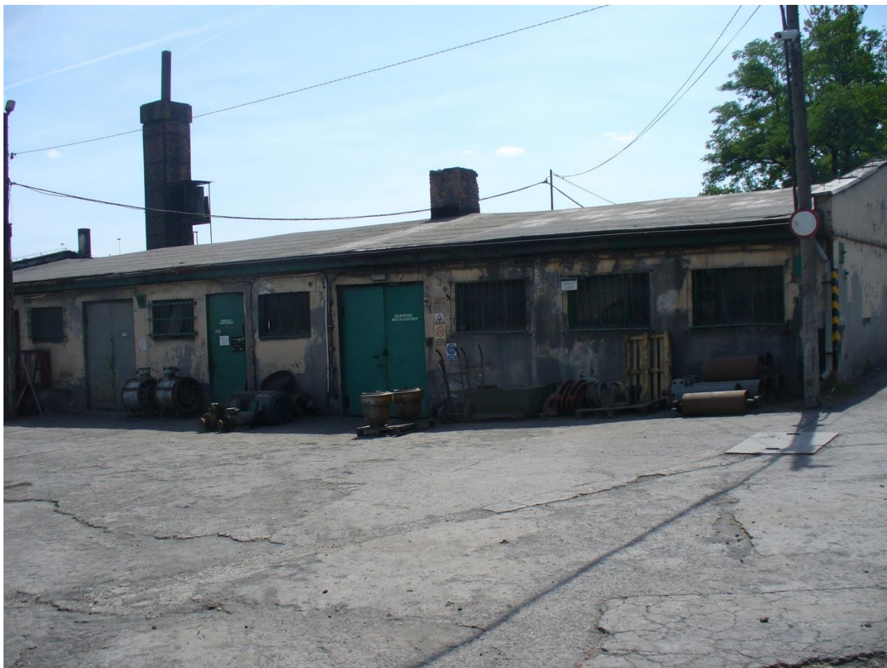
Fot. 11. Budynek warsztatu, magazynu i kotłowni.
