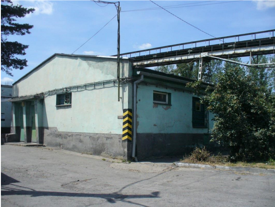
Fot. 10. Budynek łaźni i archiwum.
