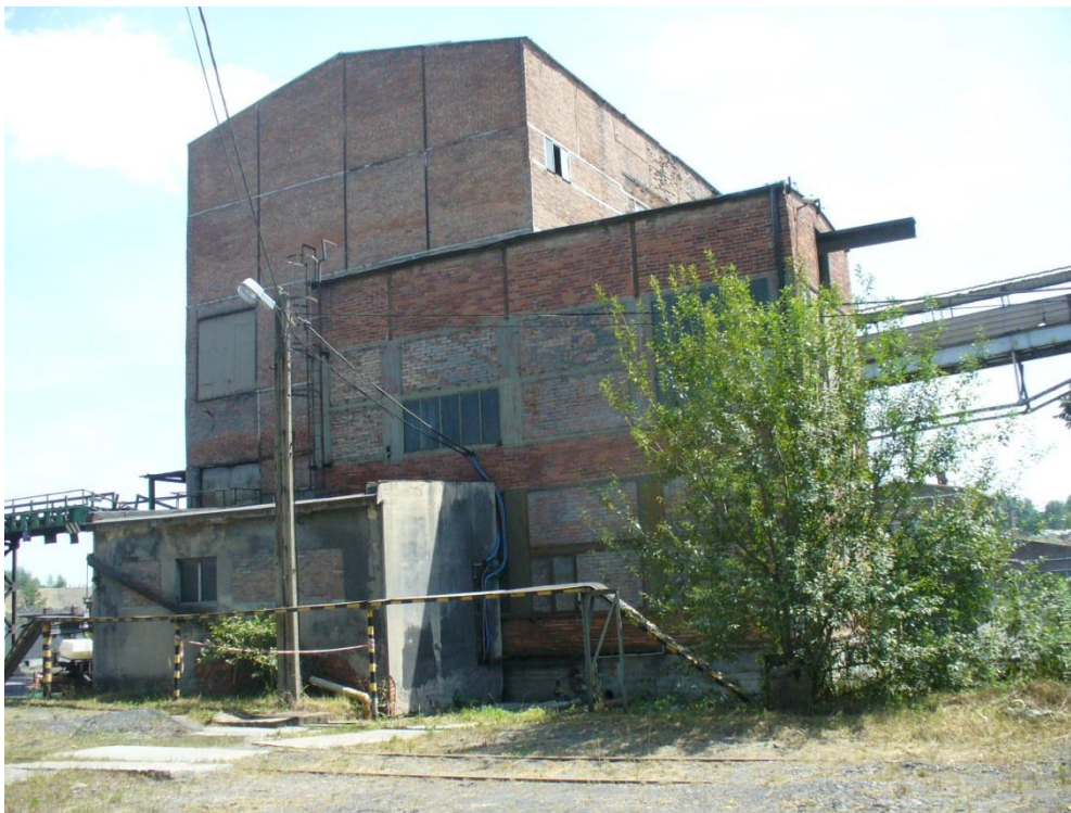
Fot. 5. Fot. Budynek rozdzielni RS15. Dalej budynek wirówki a następnie płuczki.
