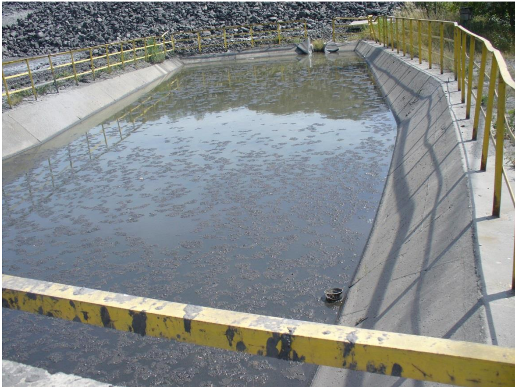
Fot. 36. Zbiornik wody deszczowej.
