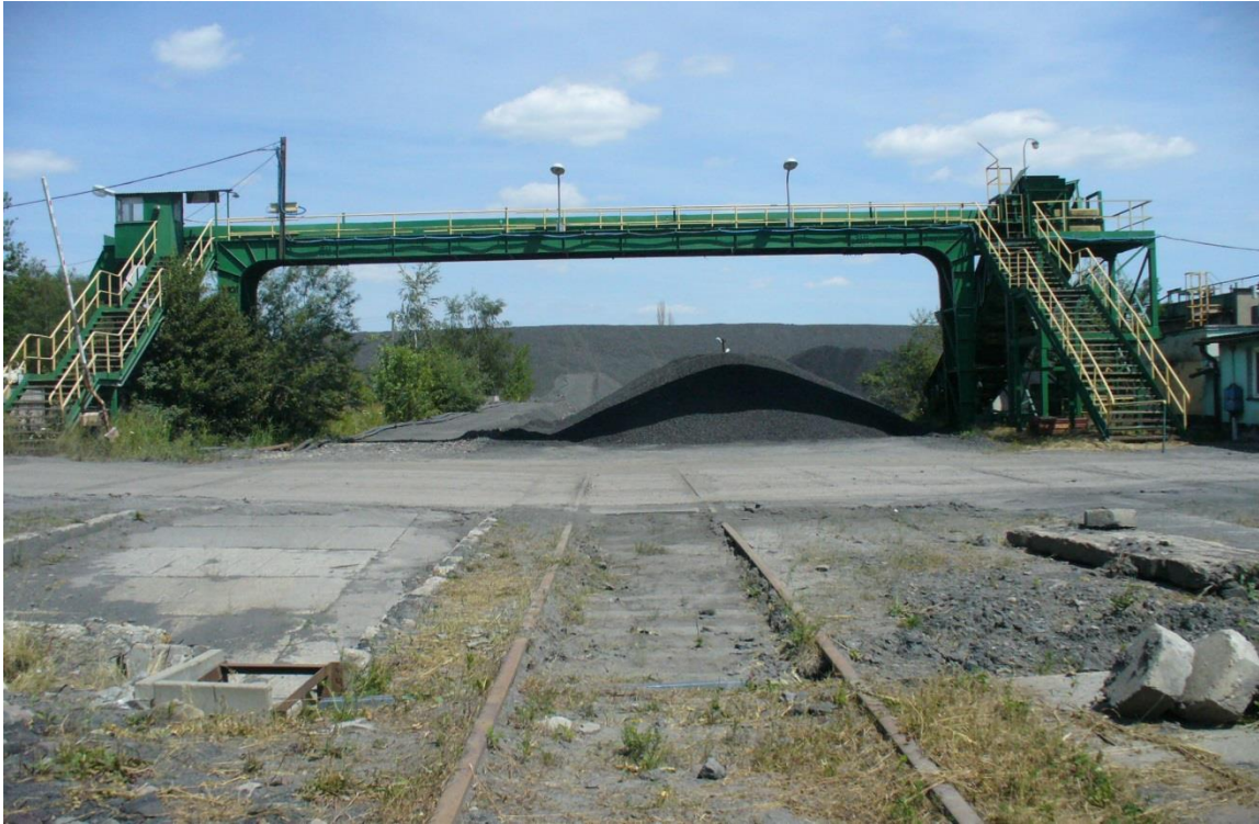
Fot. 30. Pomost dla pieszych nad torami z taśmą T-215
