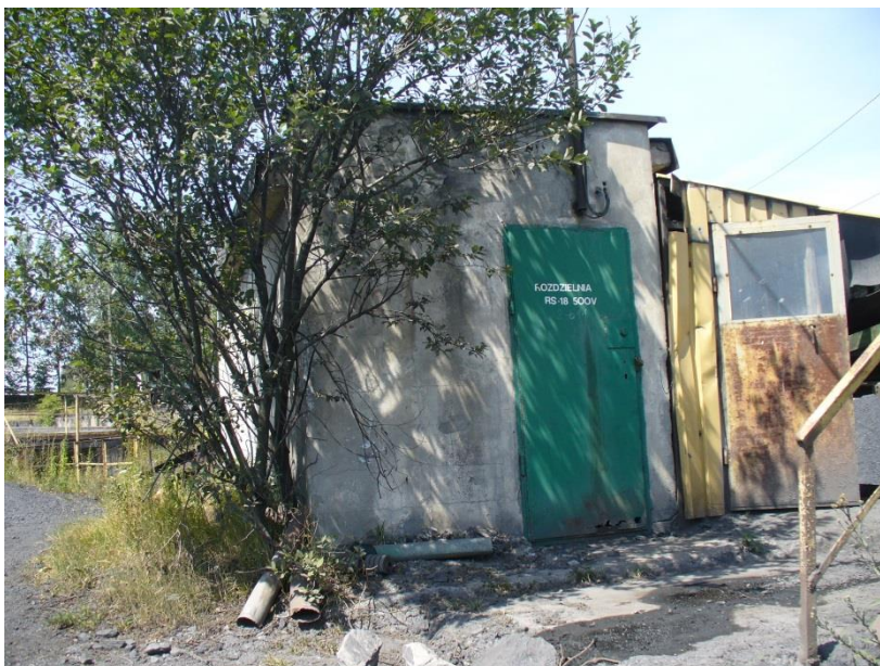
Fot. 4. Budynek rozdzielni RS18.
