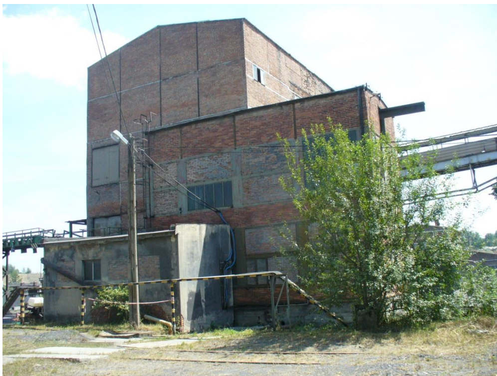
Fot. 20. Widok budynku płuczki od strony północno-zachodniej. Przed budynkiem płuczki budynek wirówki i rozdzielni RS15.
