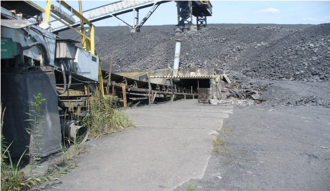
Fot. 31. Wlot lunety pod stożkiem materiału surowego 129 oraz stacja przesypowa T-123/10
