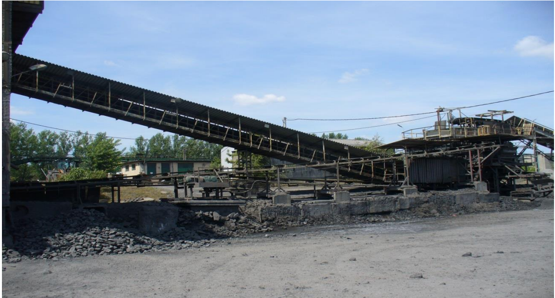
Fot. 24. Pomost T-10 ze zbiornikiem 5.
