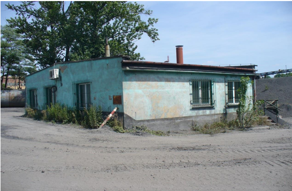
Fot. 14. Budynek laboratorium.
