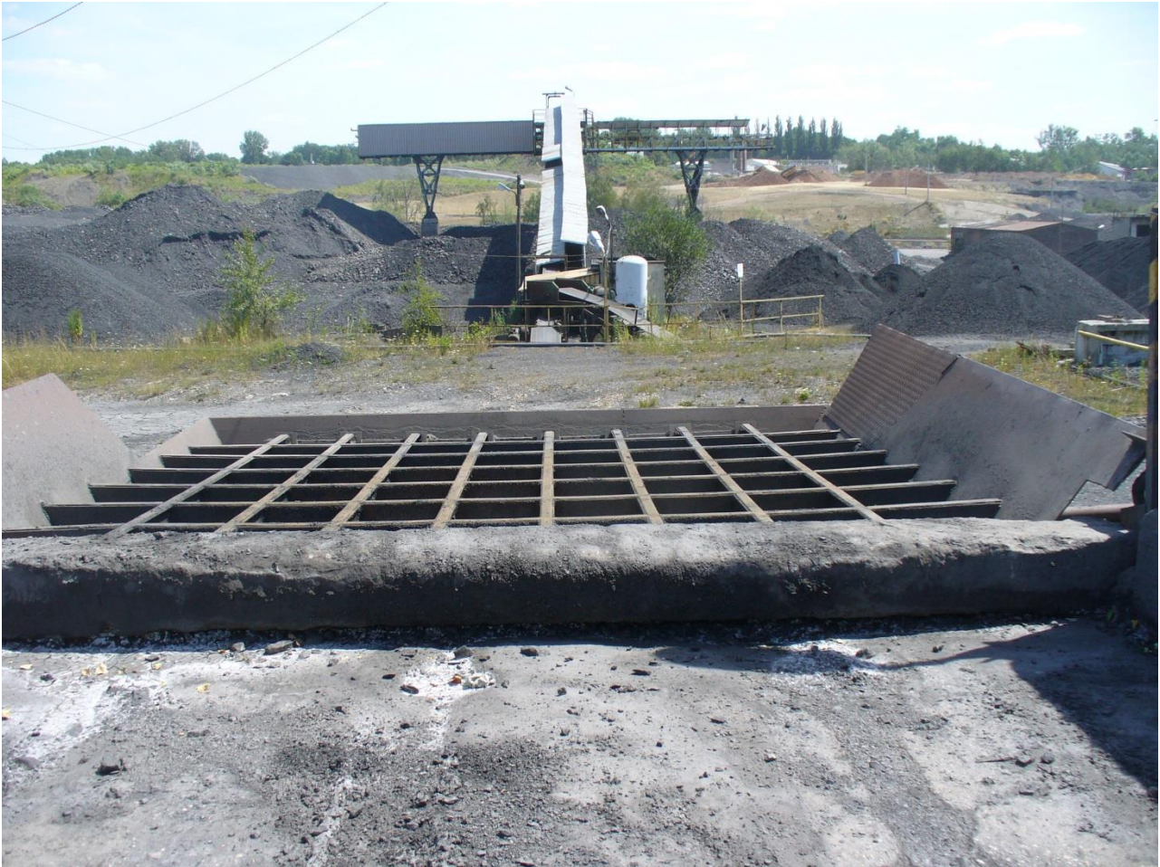
Fot. 35. Zbiornik rozładunku samochodów z przenośnikiem T-4 na T-7, tunel pod torami.
