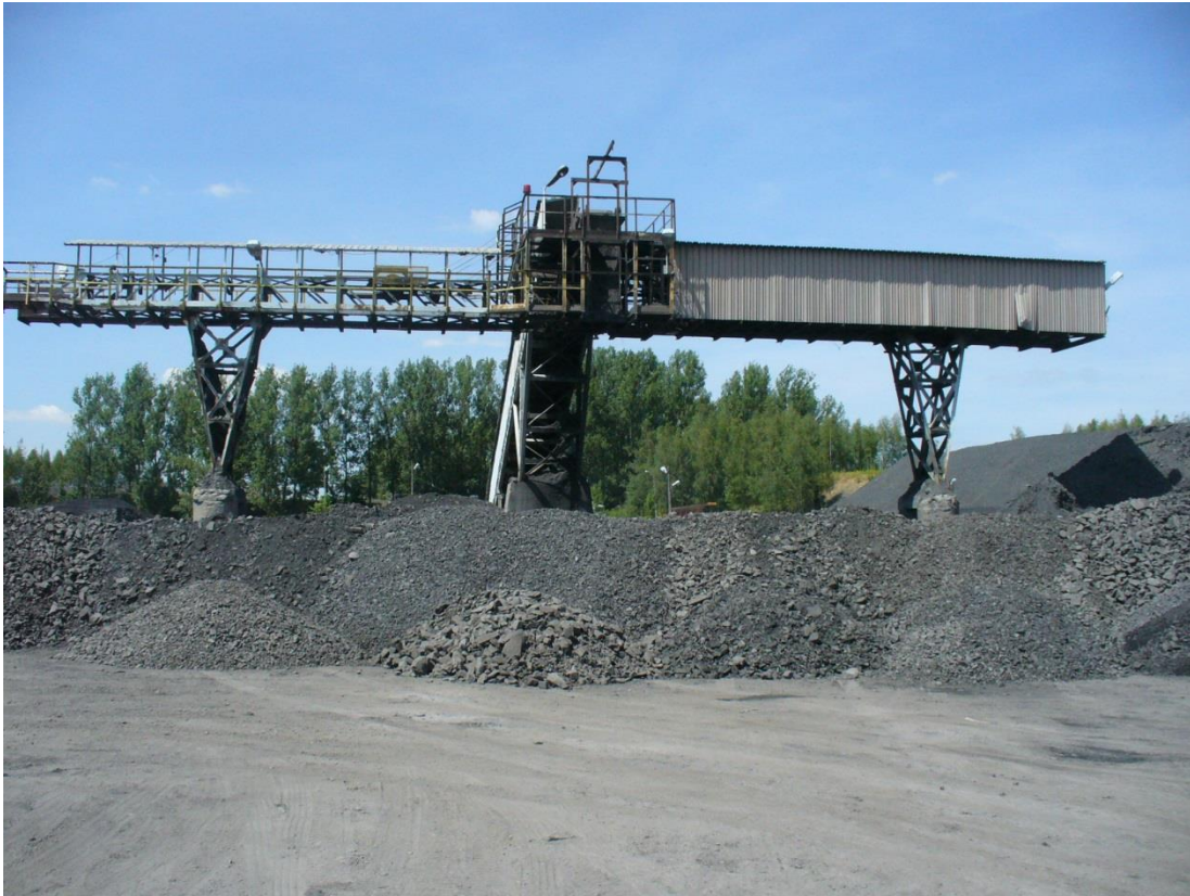
Fot. 34. Pomost taśmy rewersyjnej T-7a.
