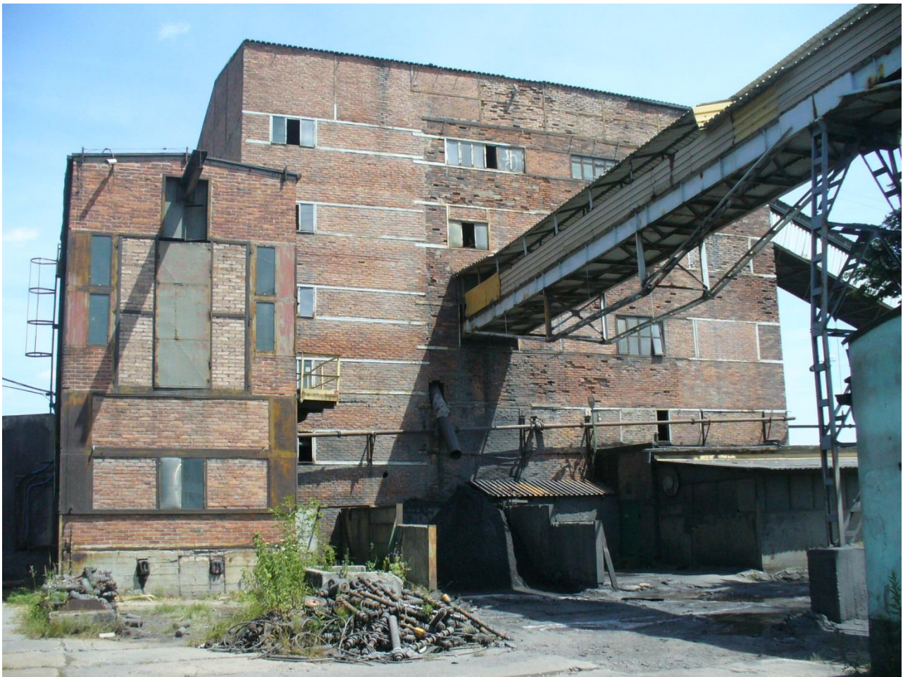
Fot. 16. Budynek wirówki, z prawej strony budynek płuczki.
