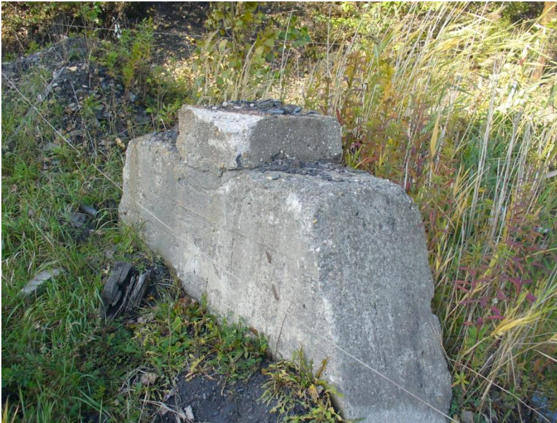
Fot. 3. Żelbetowy fundament po zdemontowanym słupie.
