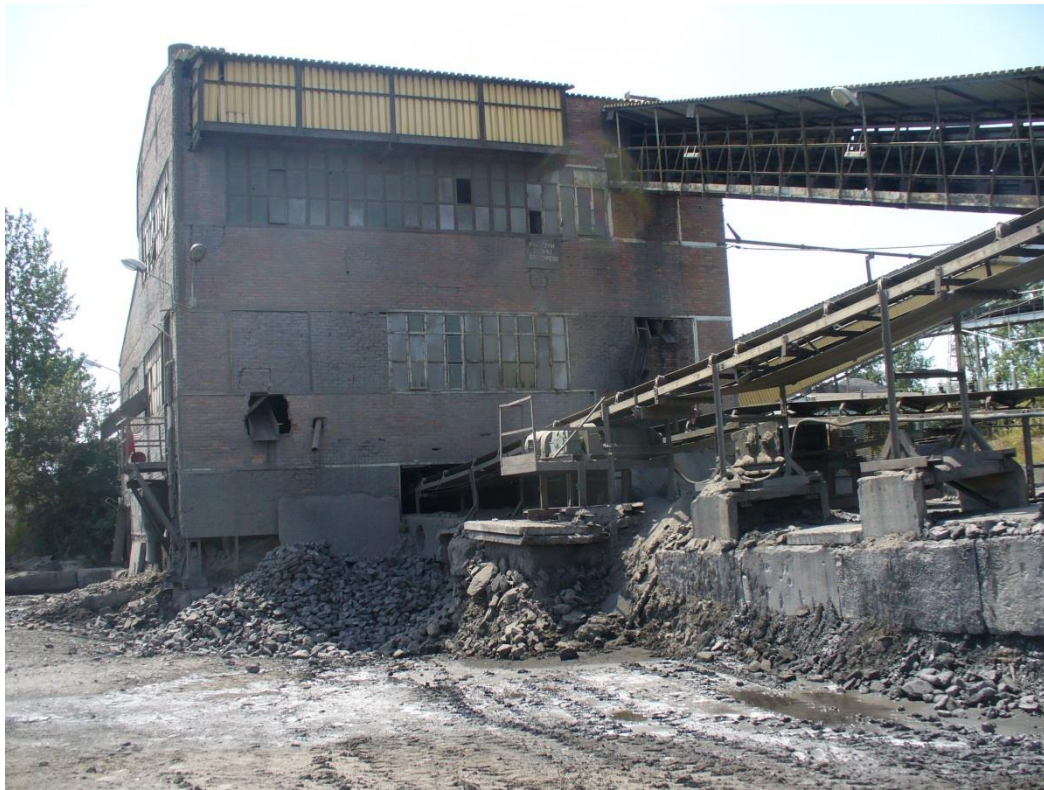
Fot. 23. Widok budynku sortowni od strony północno-wschodniej.
