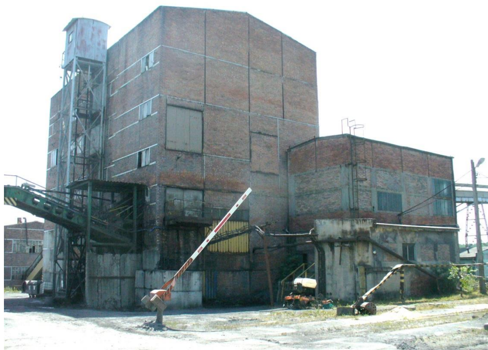
Fot. 19. Widok budynku płuczki od strony północnej.
