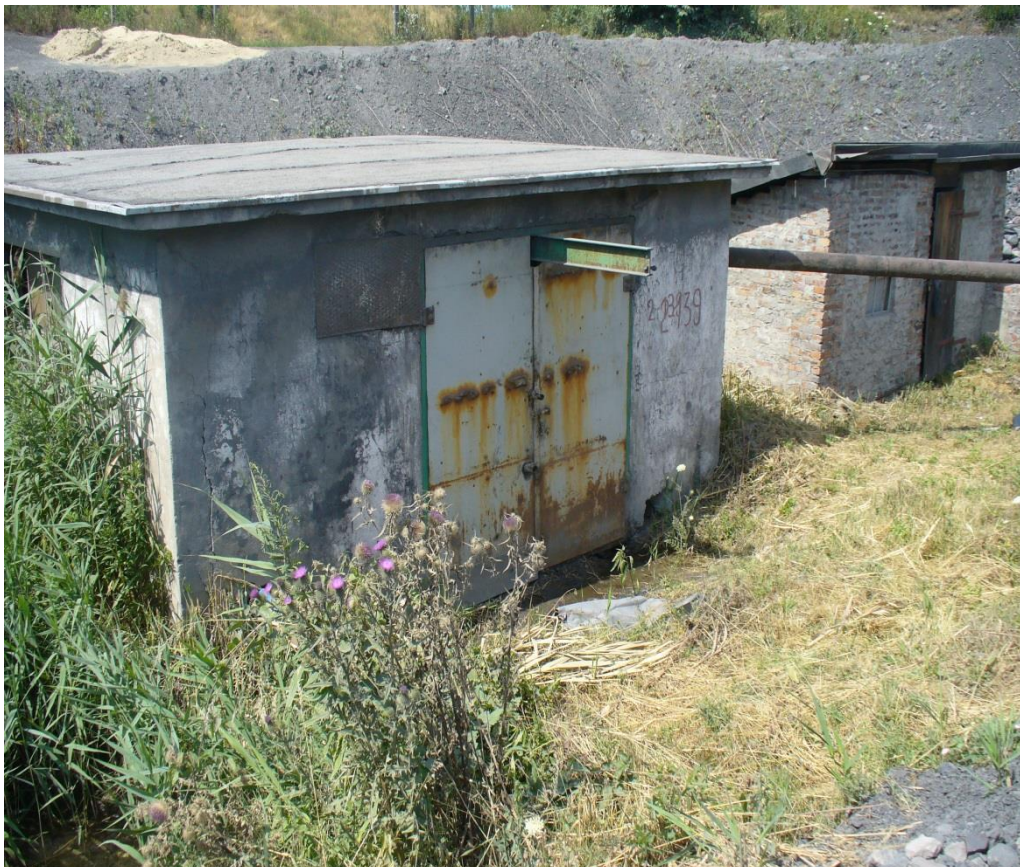
Fot. 33. Budynki pompowni peryferyjnych na boczniczy PKP.
