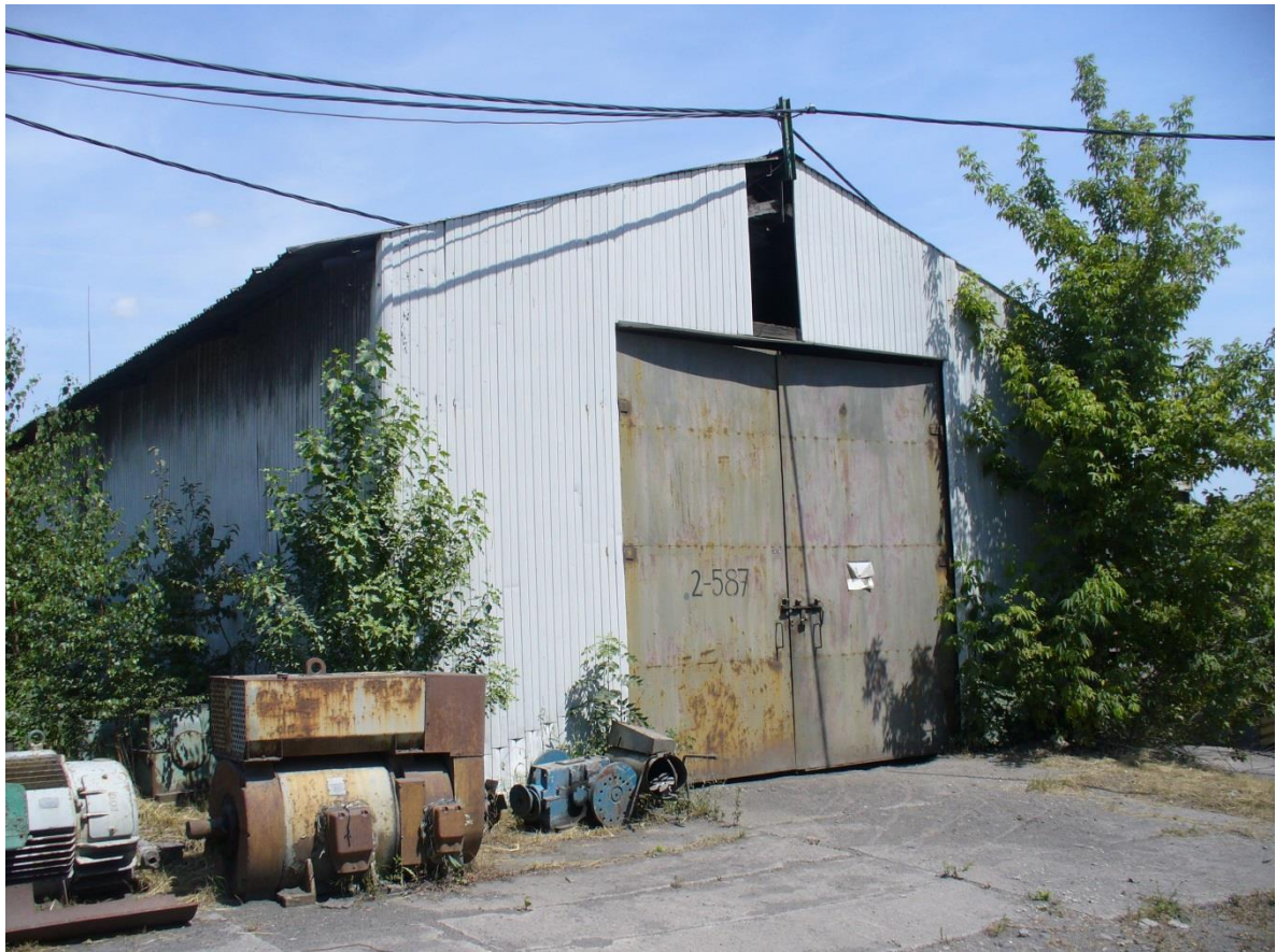
Fot. 7. Budynek obudowanej wiaty „Miedary”.
