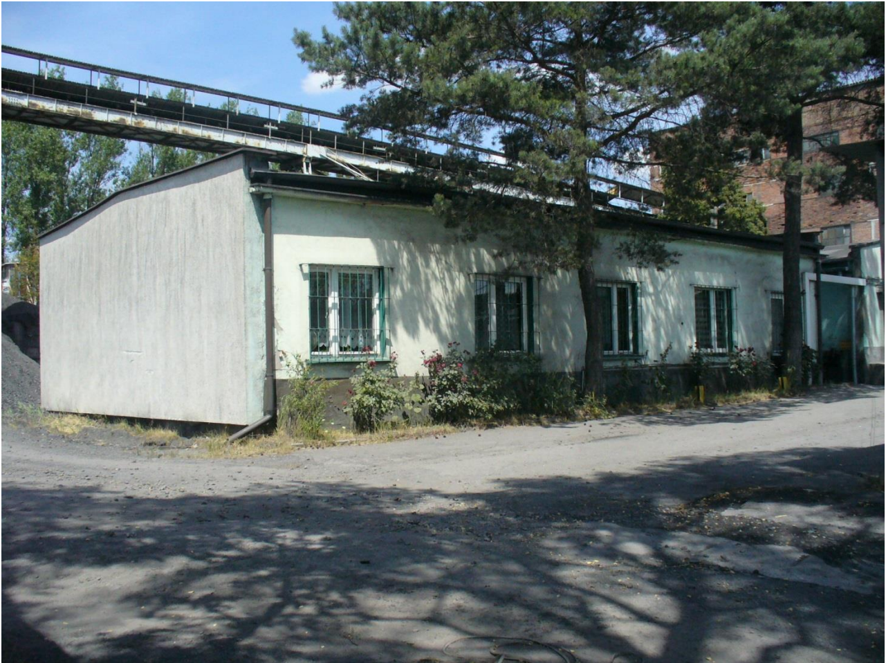
Fot. 13. Budynek administracji.
