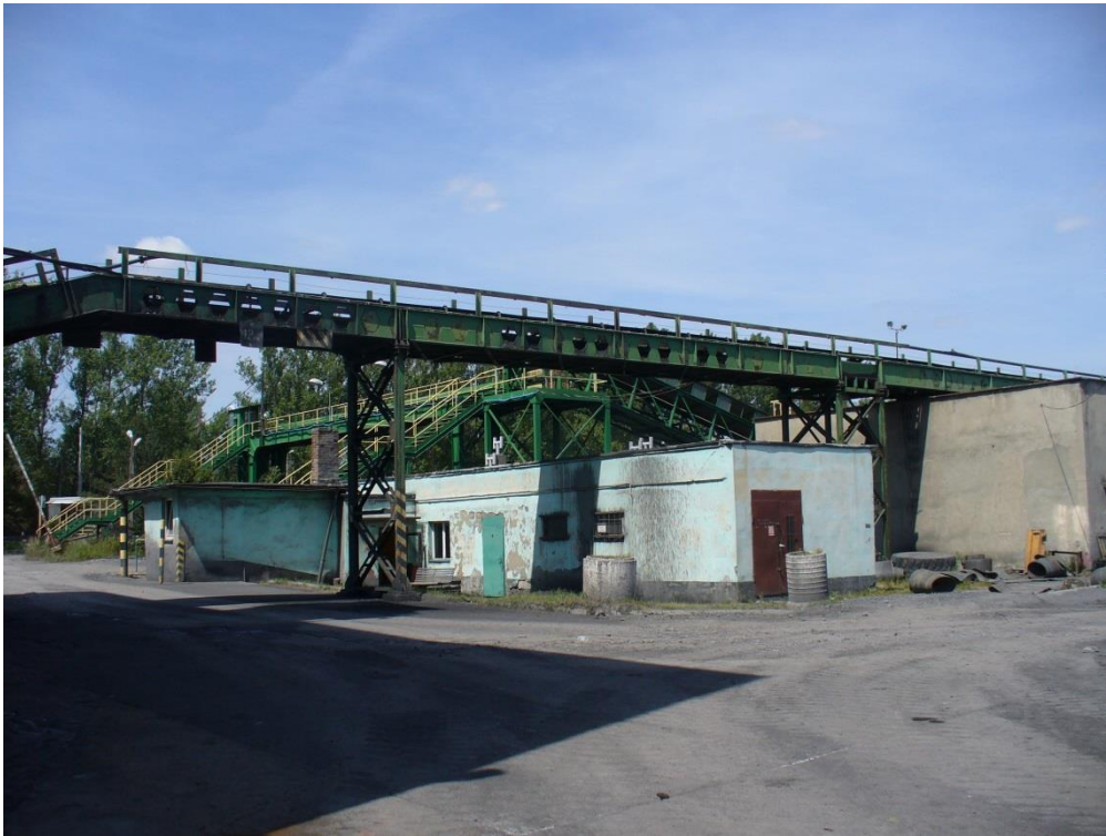
Fot. 37. Pomost taśmy T-50 odstawy węgla na składowisko.
