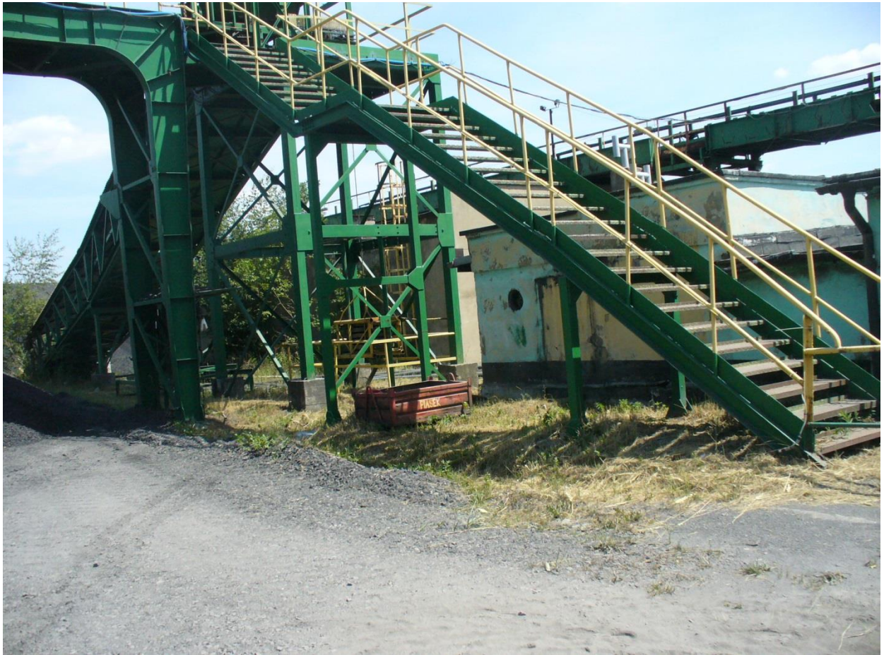
Fot. 39. Pomost taśmy T-214 (usytuowany za schodami)
