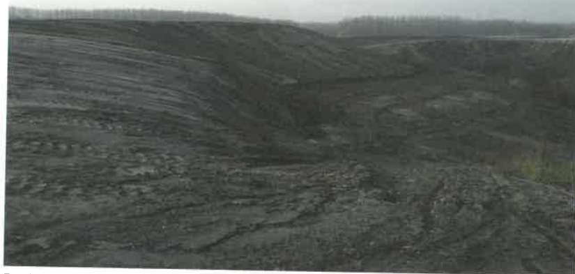
Fot. 1. Rekultywacja techniczna obiektu „AJSKA” w Świętochłowicach
